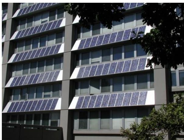
Slika 5. Primjena FN panela na fasadi zgrade
