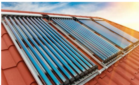
Slika 1. Vakuumski cijevni solarni kolektori
