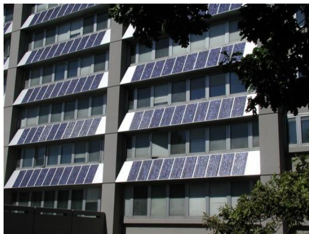
Slika 4: Namestitev sončnih panelov na fasado stavbe
